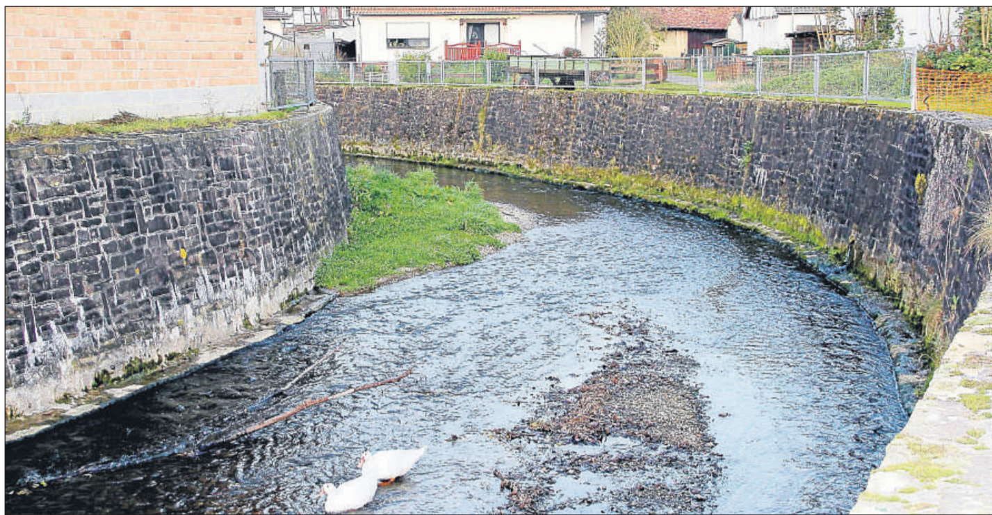
Trügerisches Idyll: Trotz hoher Ufermauern drängt die Warme bei massiven Unwettern schlimmstenfalls in die Ortslage von Obermeiser. Fotos: Binienda-Beer
