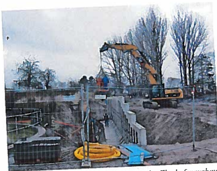
Erweiterung der Kläranlage im Zuge des Flughafenbaus
