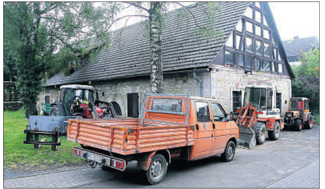
Hier soll das Ausstellungs- und Erlebniszentrum entstehen: Die Arbeiten sollen in einem Teil des Obergeschosses des alten Eisenhammergebäudes beginnen, das derzeit noch - unter Auflagen - als Bauhof genutzt wird. Endgültig ausziehen wird der Bauhof erst, wenn ein neuer Bauhof errichtet ist. Der Beschluss darüber wurde aber zunächst vertraglich. Foto: Thiele
