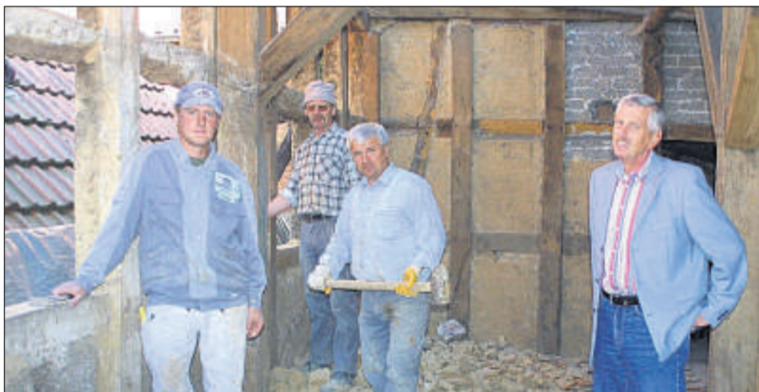
Der Abbruch hat begonnen: Die Gefache an der Westseite der Scheune werden per Hand entfernt, um eine Beschädigung des Nachbarhauses auszuschließen. An der Ostseite kommt heute der Abrissbagger zum Einsatz. Unser Bild zeigt Bürgermeister Amin Kölling beim Ortstermin mit (von links) Sebastian Poppke und seinen Mitarbeitern Ewald Arendes und Andreas Pagacz.
