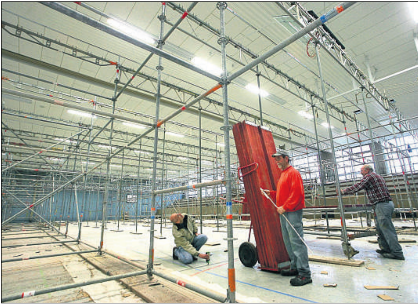
Wald aus Gerüststangen: Ein 7000 Kubikmeter umfassendes, fast raumfüllendes Baugerüst erhob sich noch in dieser Woche in der Kreissporthalle. Es war nötig, um neue Beleuchtungen und Heizelemente an der Decke zu montieren. Im Bild ist Architekt Knut Warmuth (links) mit zwei Arbeitern einer Baufirma, Manfred Bussang (Mitte) und Andreas Holzwert, bei Messarbeiten zu sehen. Fotos: Thiele
