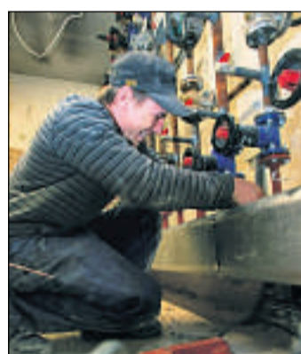
Endspurt: Heizungsbau-Geselle Manuel Rassler (Borken-Dillich) arbeitete an der Heizungsverteilung.
