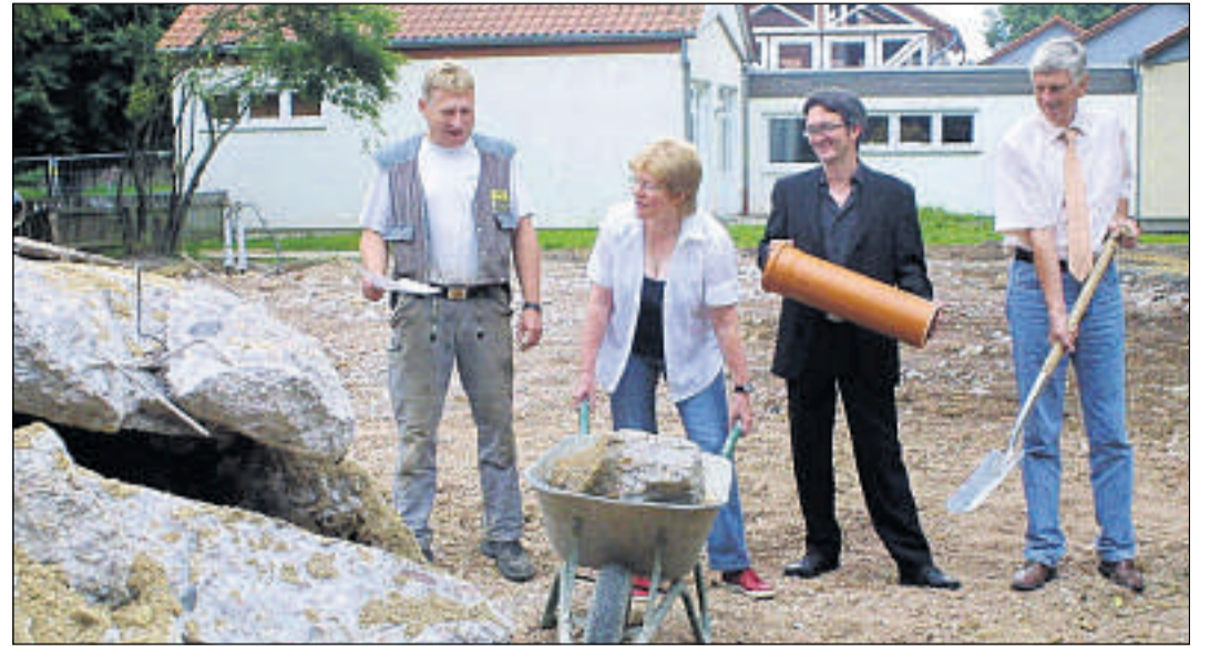
Bauarbeiten: Kindergartenleiterin Ursula Franck fährt die letzte Fuhre mit Gestein zum Abladeplatz, während Bürgermeister Armin Kölling auf den ersten Spatenstich wartet. Bevor Bauunternehmer Thomas Söhnchen (links) loslegen kann, müssen nach Angaben von Architekt Clemens Kober die Abwasserleitungen gelegt werden. Ist sie ausgetrocknet.
