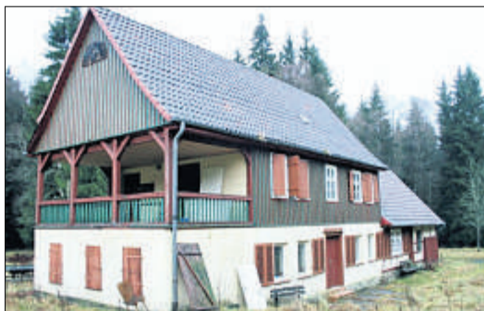
Das Steigerhaus: So sah es aus. Trotz Abriss soll nun ein Gebäude entstehen, das dem Original identisch sein wird.
