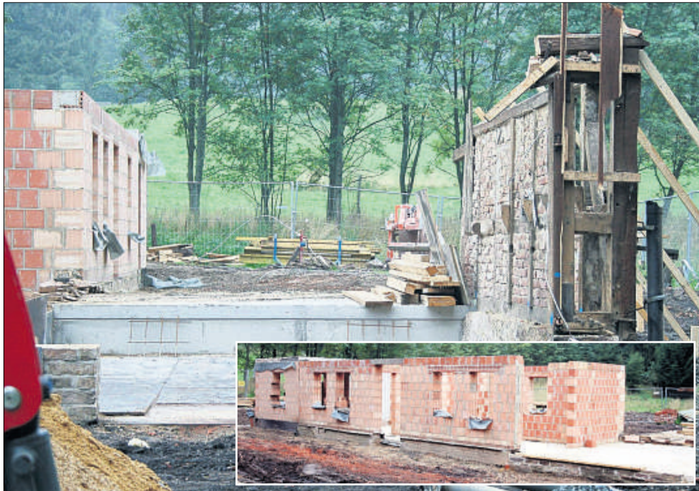
Das Steigerhaus ist Vergangenheit: In der vergangenen Woche wurde es abgerissen. Auf seinem Grundriss wird derzeit ein neues Bauwerk errichtet (kleines Bild). Geliebte Erinnerung: Die alte Mauer rechts (großes Foto). Fotos: Thon
